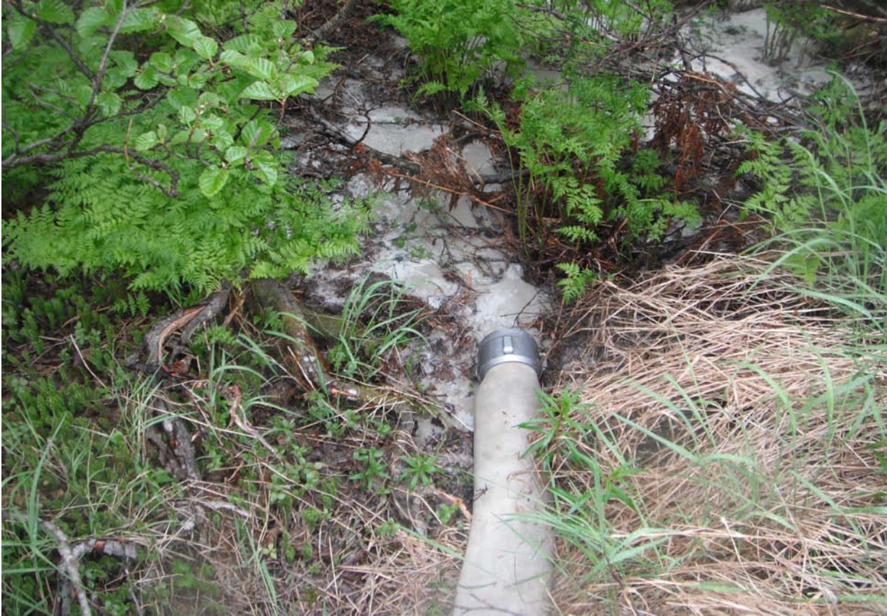
Figure 4 – DH 11533 Discharge Point
